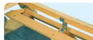
УКРЕПВАНЕ НА ПОКРИВА
